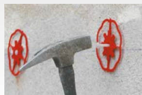
A Baumit ragasztótárcsát a furatba kell illeszteni és a műanyag tűske beütésével rögzíteni.
